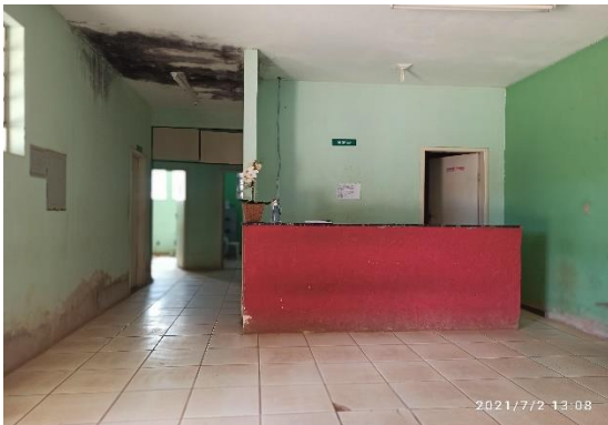
Imagem 03: Área de circulação. É visível a umidade nas paredes e tetos e piso estourado.
