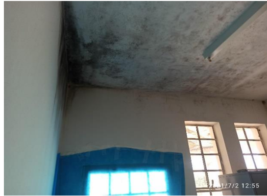
Imagem 07: Laje com infiltração em quase todos os cômodos.
