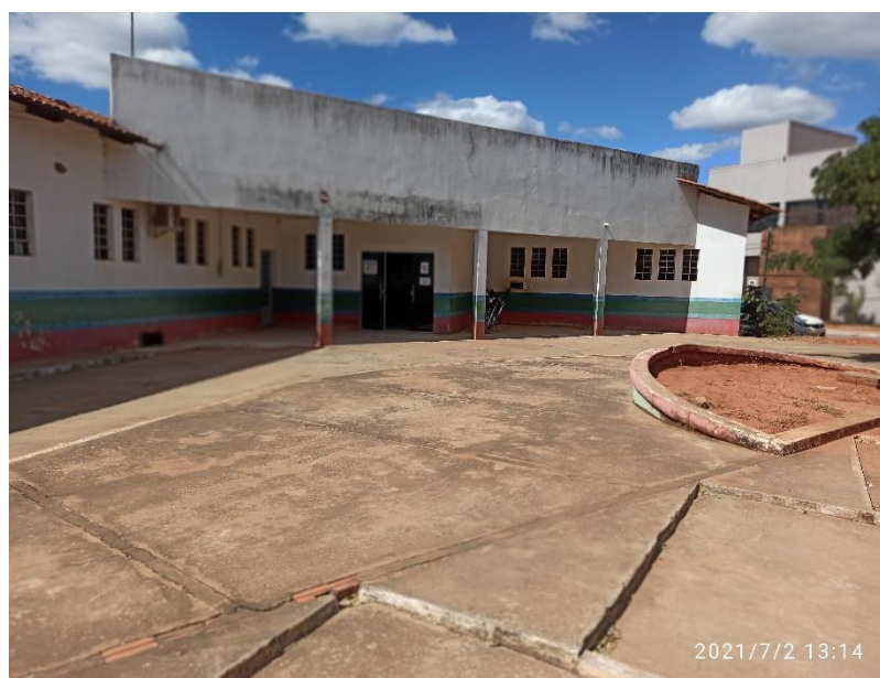
Imagem 02: Correção de infiltração da laje de entrada
