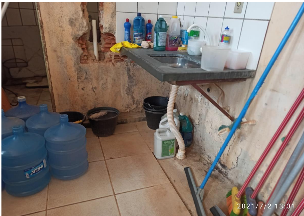
Imagem 05: Situação da sala onde hoje encontra-se o almoxarifado.
