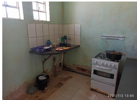
Imagem 03: Área de circulação. É visível a umidade nas paredes e tetos e piso estourado.
