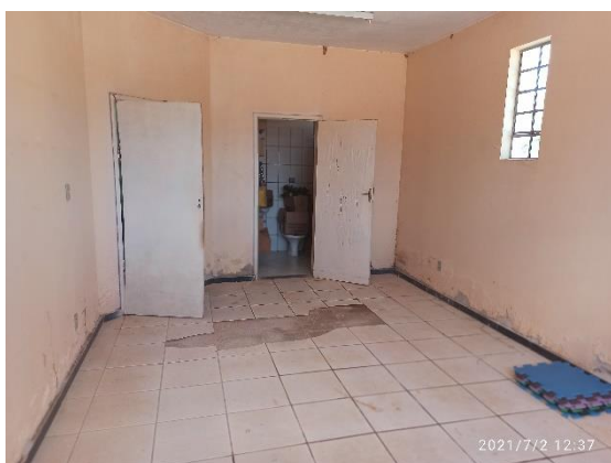
Imagem 09: Corredor com infiltração e piso danificado.
