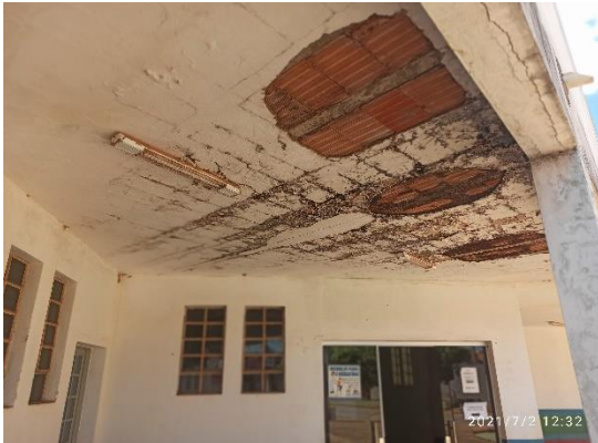
Imagem 07: Laje com infiltração em quase todos os cômodos.
