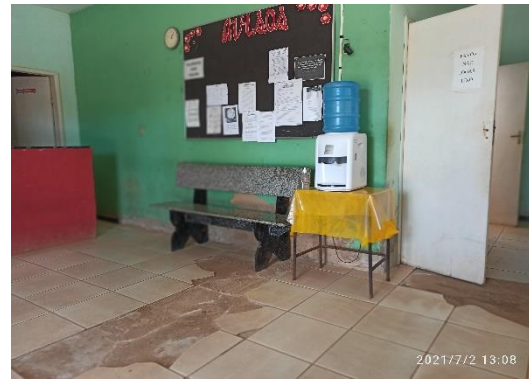
Imagem 03: Área de circulação. É visível a umidade nas paredes e tetos e piso estourado.
