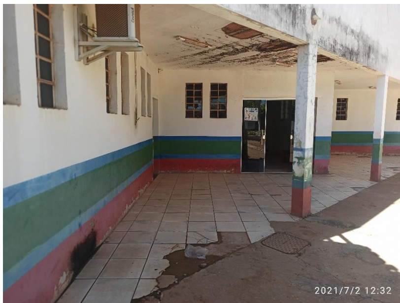
Imagem 01: Fachada do prédio da Secretaria de Saúde
