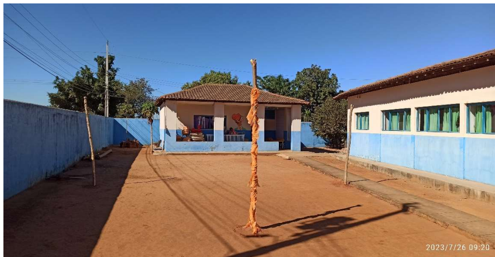
Imagem 01: Fachada do prédio
