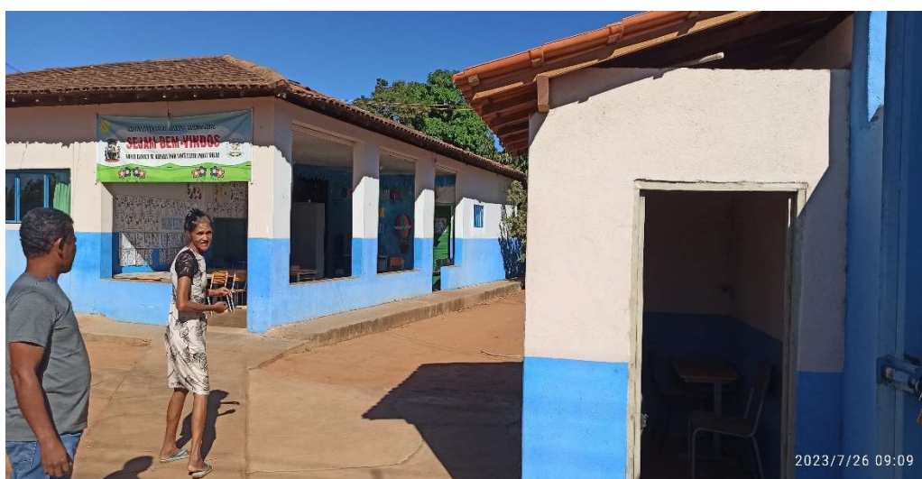
Imagem 02: Guarita e entrada principal
